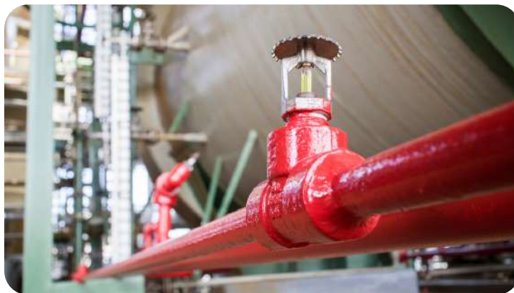
Instalación de rociadores automáticos contra incendios
