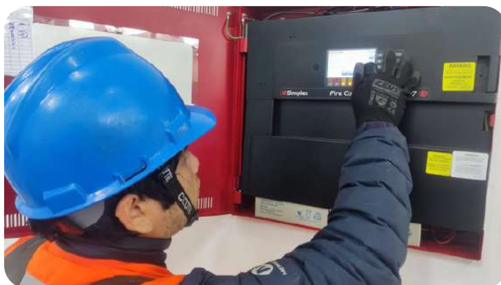
Instalación de alarmas contra incendios.
