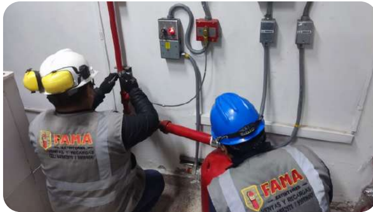
Instalación de sistemas contra incendios
