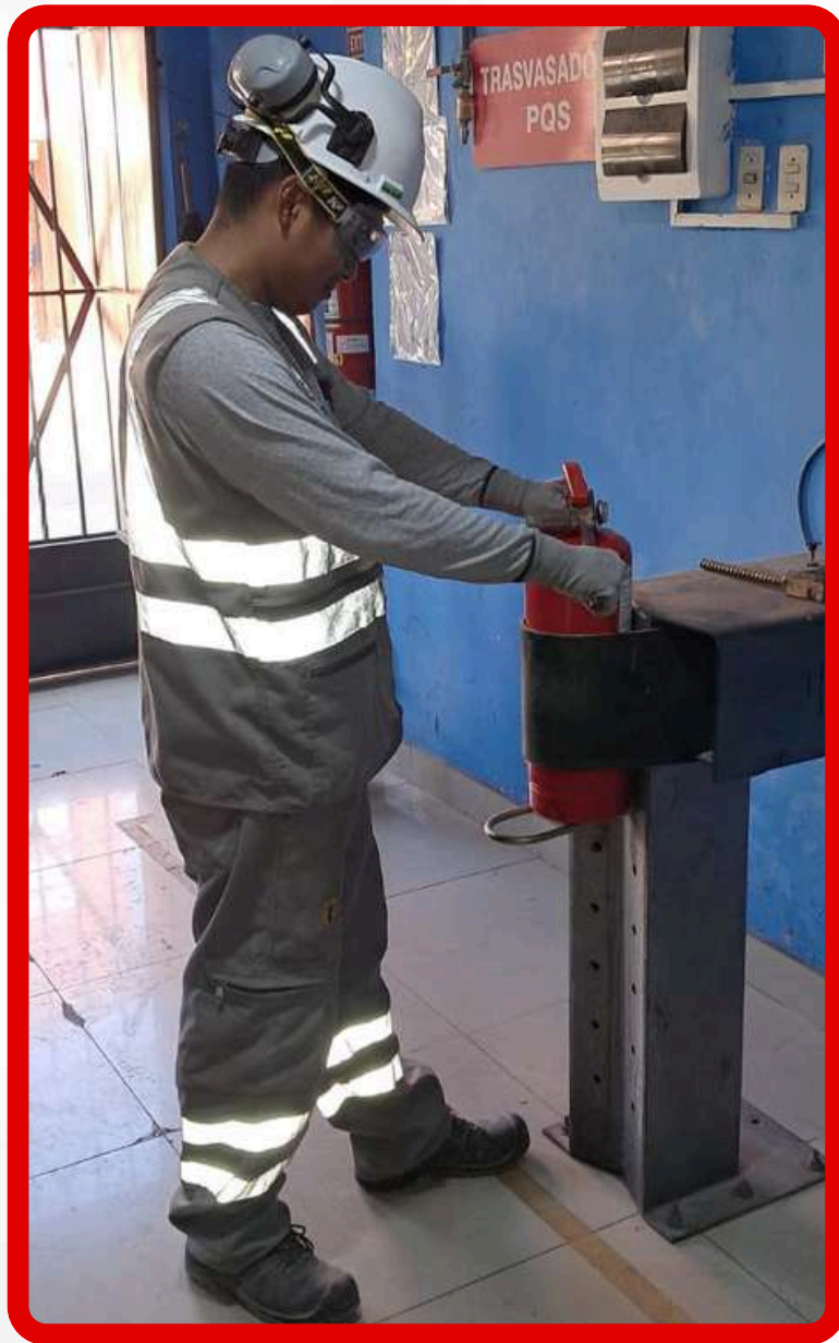
PRENSA NEUMÁTICA PARA ABERTURA Y CERRADO DE VÁLVULAS DE EXTINTORES
